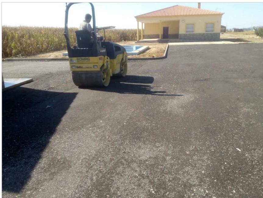
Ilustración 10. Aplicación de árido reciclado en una explanación.
